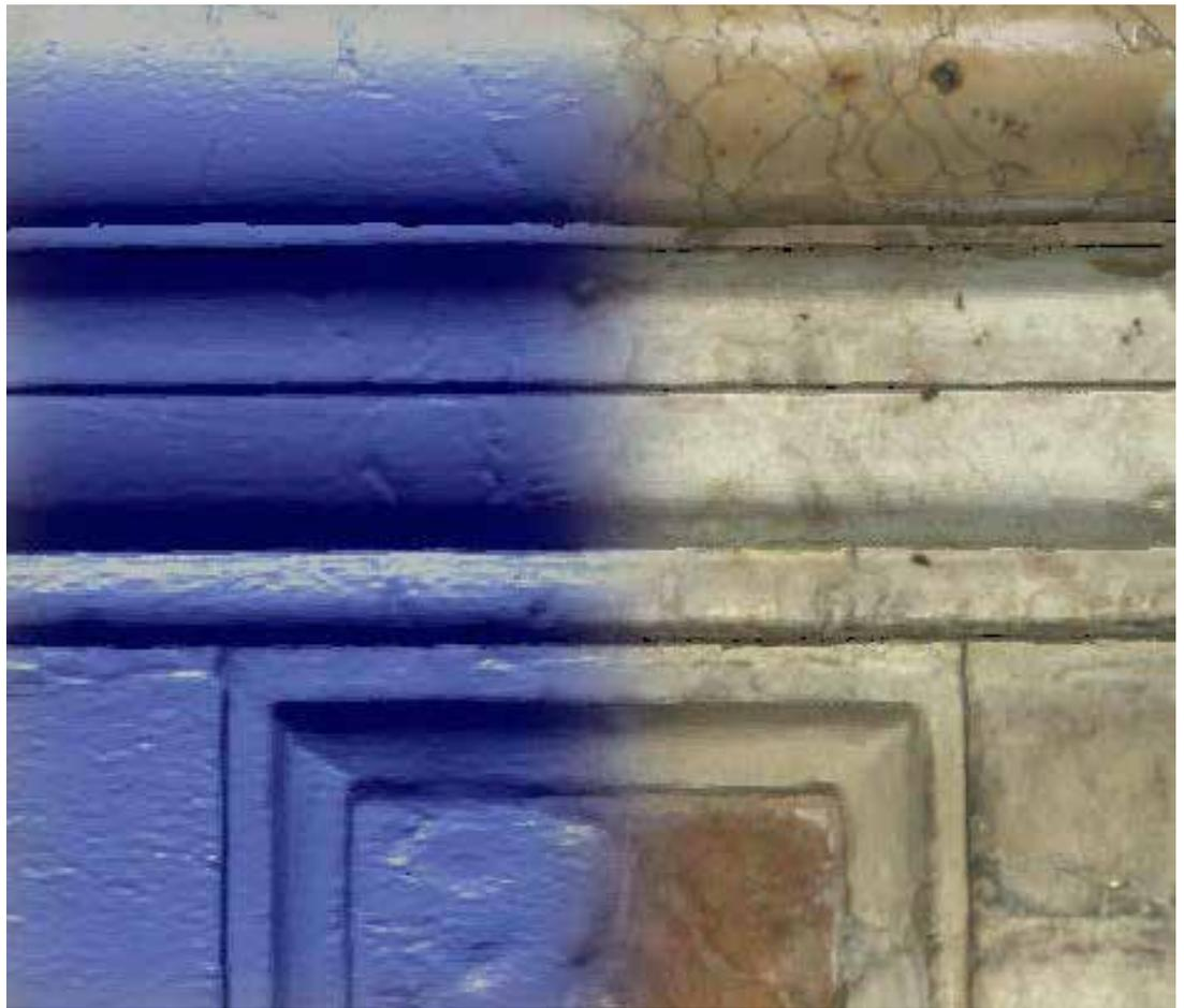
**Figura 5:** Rilievo del basamento con scanner a proiezione di luce strutturata, particolare del lato Est (ca. 30 cm x 30 cm): mesh a colori artificiali, mesh texturizzata con colore naturale, affiancamento con transizione tra i due risultati
