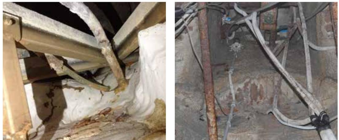
**Figura 29:** Particolare del punto di collegamento mediante un tratto di tubazione in piombo tra la tubazione di alimentazione e l'ugello per i getti dei Delfini (L2\_Castellum) (sinistra) e per getti posti al livello superiore (destra).
