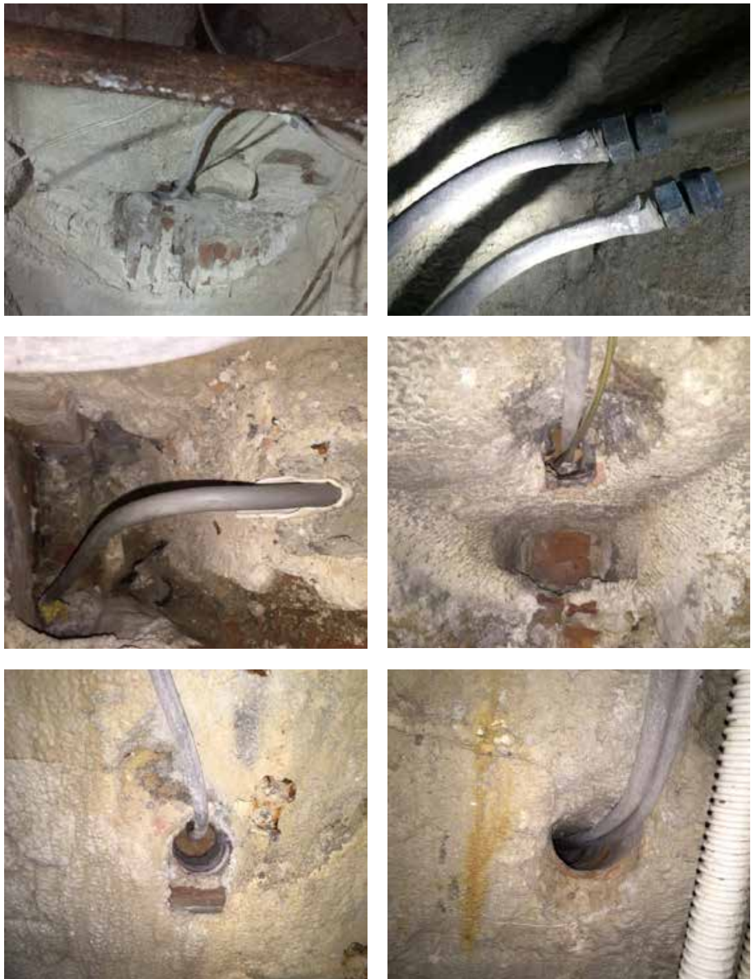
Figura 2: Particolari dell'attraversamento della muratura del Castellum delle tubazioni in piombo che costituiscono l'ultimo tratto dell'attuale impianto idraulico
