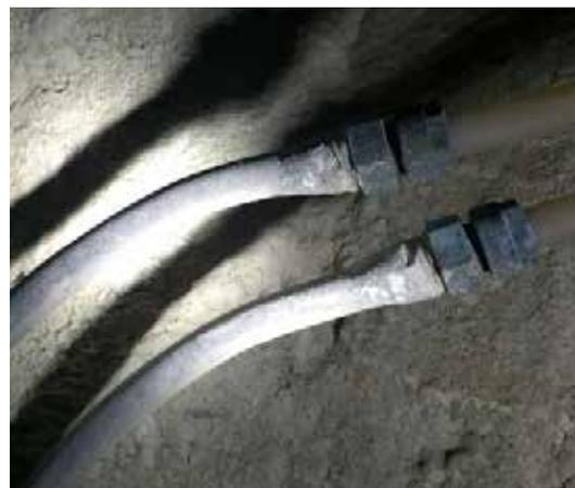
**Figura 4:** Collegamento tra le tubazioni in piombo e le tubazioni in gomma all'interno del Castellum
