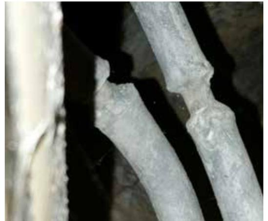
**Figura 3:** Collegamento tra diametri diversi delle tubazioni in piombo
