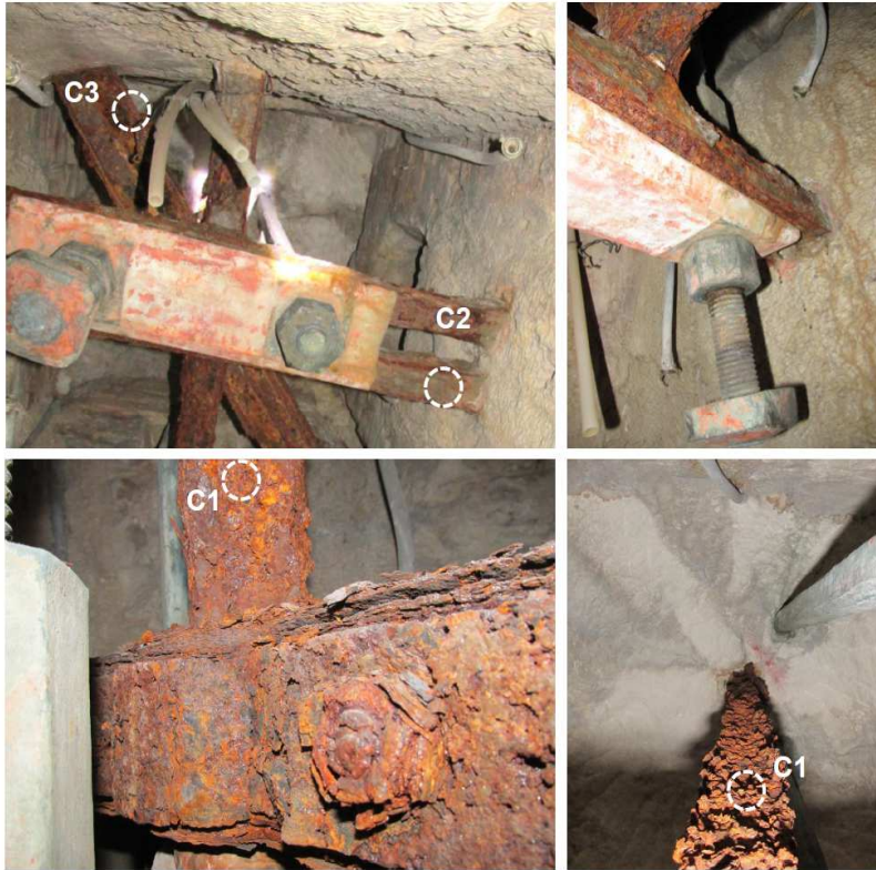
STRUTTURA INTERNA – PUNTI DI PRELIEVO PER ANALISI
